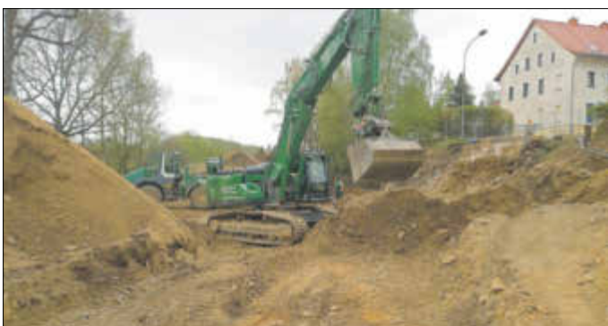
Rückbau ehemalige Bahnbrücke OT Halsbrücke
