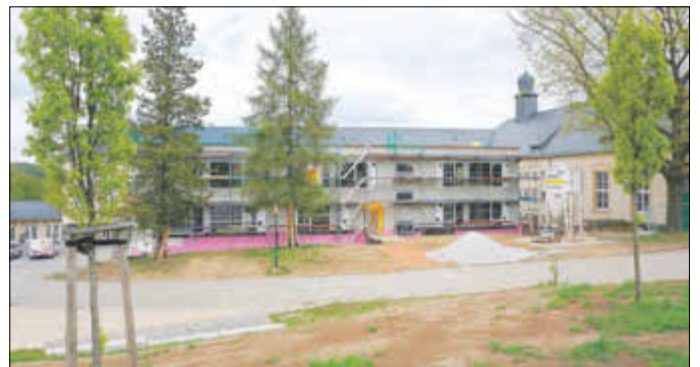
Erweiterungsbau Oberschule Halsbrücke
